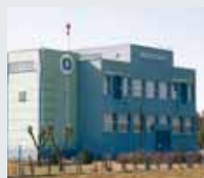
Miejskie Wodociągi i Oczyszczalnia, Grudziądz, Polska
